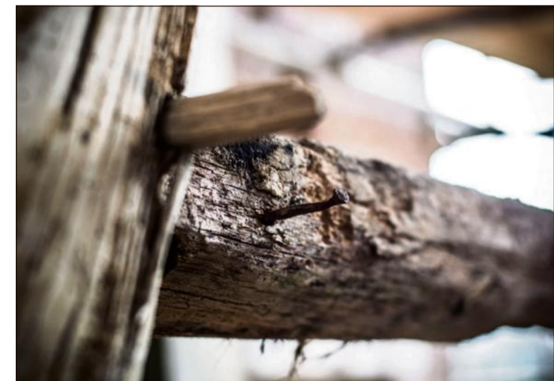
Oude spanten zijn opnieuw aangebracht, ook in het nieuwbouwgedeelte.
