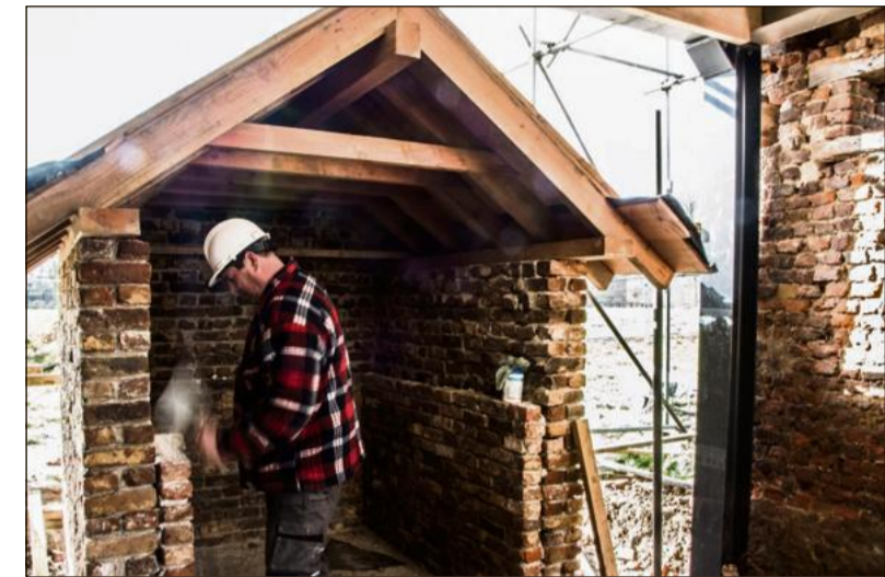
De bakkersoven in het originele deel in aanbouw.
